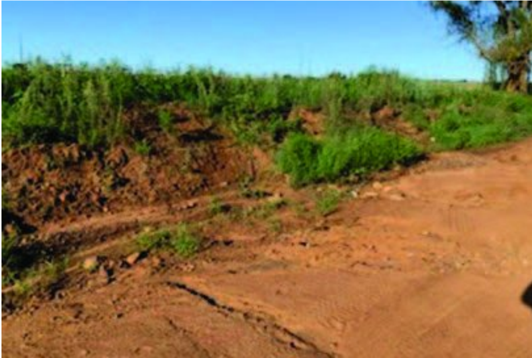
'n Grondwal en slote in die pad
