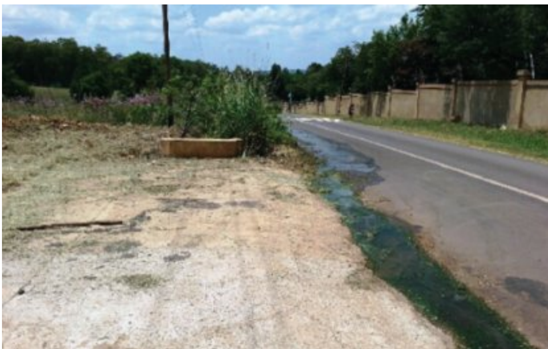
Die rioolwater stroom bo-oor die watersloot op pad na Achillesweg Foto: Annemarie de Villiers
