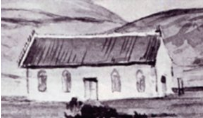
Die eerste kerk in Pretoria in 1857, die Nederduitsch Hervormde kerk "Pretoria-Philadelphia". Dié Foto: Gereformeerde Kerk, Pta
